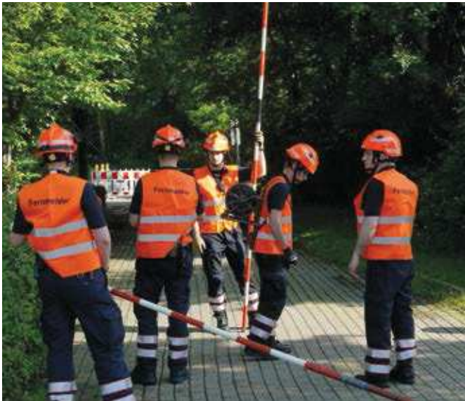
Feldkabelbautrupp der FE IuK Cuxhaven beim Verlegen einer Feldkabelleitung zwischen Katastrophenschutzstab und Bereitstellungsraum während der Übung Seefalke 2014.
