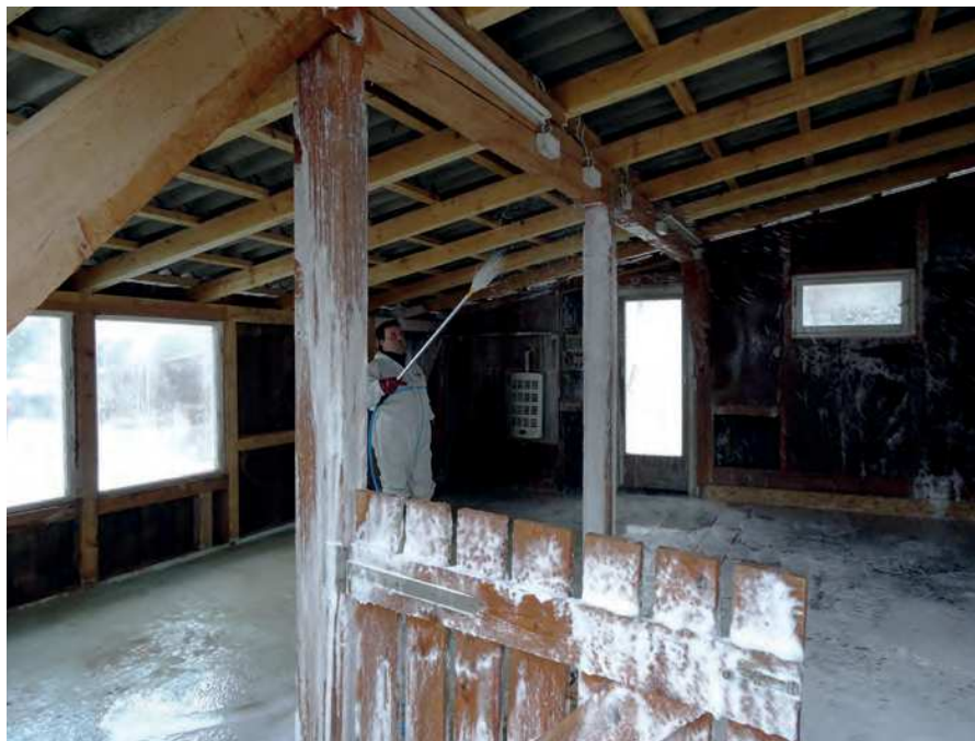
Dekontamination von betroffenen Ställen.
